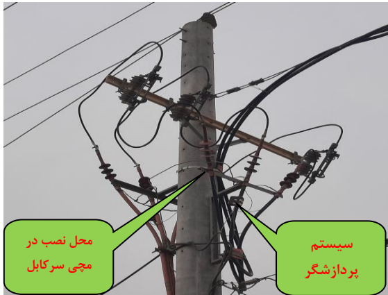
شکل (۸): نصب دستگاه بر روی سرکابل های هوایی
